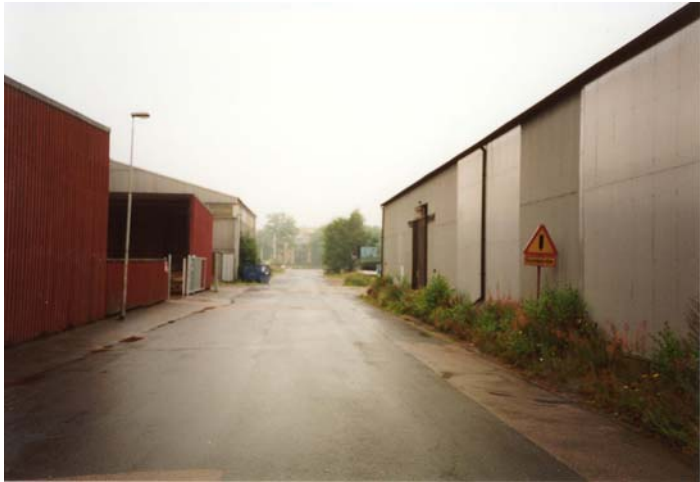
Industrigata med lagerbyggnader i plåt på vardera sidan.
