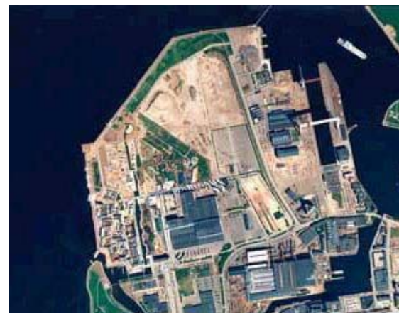
Flygbild på Västra Hamnen där den nya bebyggelsen skymtas till vänster i bild. 17
