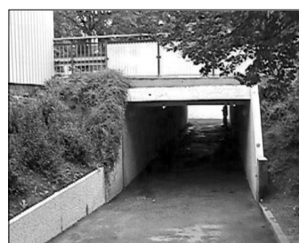
Tunnel för gång- och cykeltrafik.
