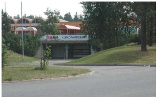
Nedfart till parkeringsgaraget
