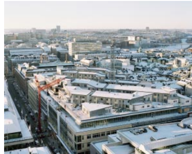
Projektet Klara Zenit, där radhus byggs ovanpå befintliga kontor och butiker mitt i Stockholm City. Foto © Equator 2003
