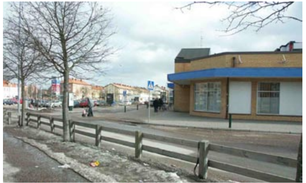
Bild 5-6. Platsen blir gradvis synlig.
