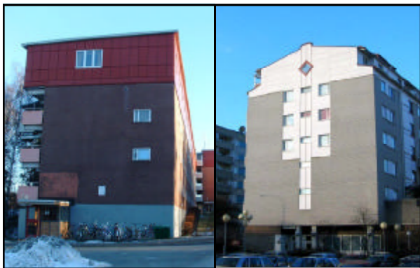
Påbyggnad i Karolinska sjukhusområde, Solna och i Hallonbergen, Sundbyberg
