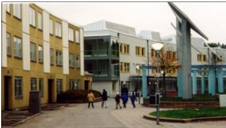
Bild 10: Ombyggd del av Guldringen, Proffice kontor
