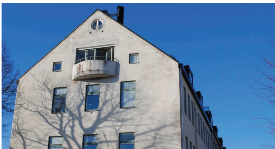
Tillbyggnad på Beklädnadsverkstaden
