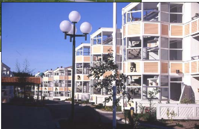
Fig 9. Fasadernas utseende efter ombyggnationen
