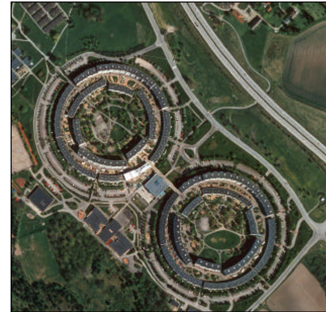
Navestad med sina "ringar".
