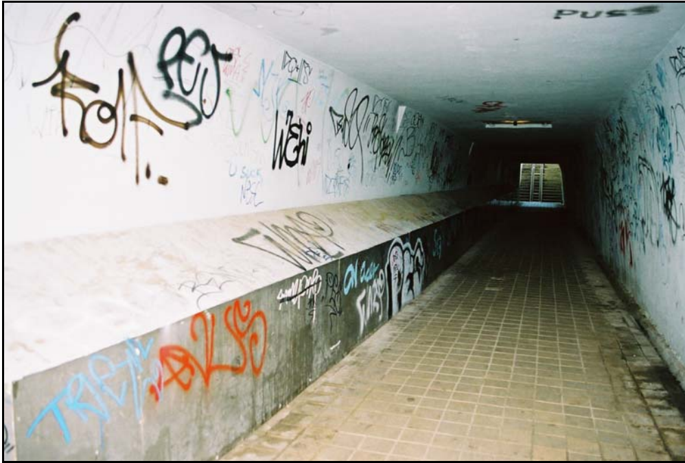
Gångtunnel som förbinder stationsområdet med Bangatan.
